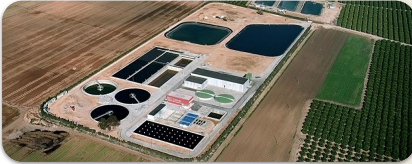
Proyecto llevado a cabo en la EDAR de San Javier (Murcia) Project carried out in San Javier (Murcia)'s WWTP
